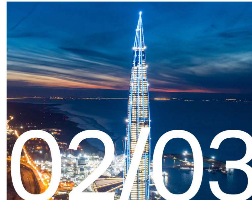
УМНОЕ ЗДАНИЕ ФАСАДНОЕ ОСВЕЩЕНИЕ
